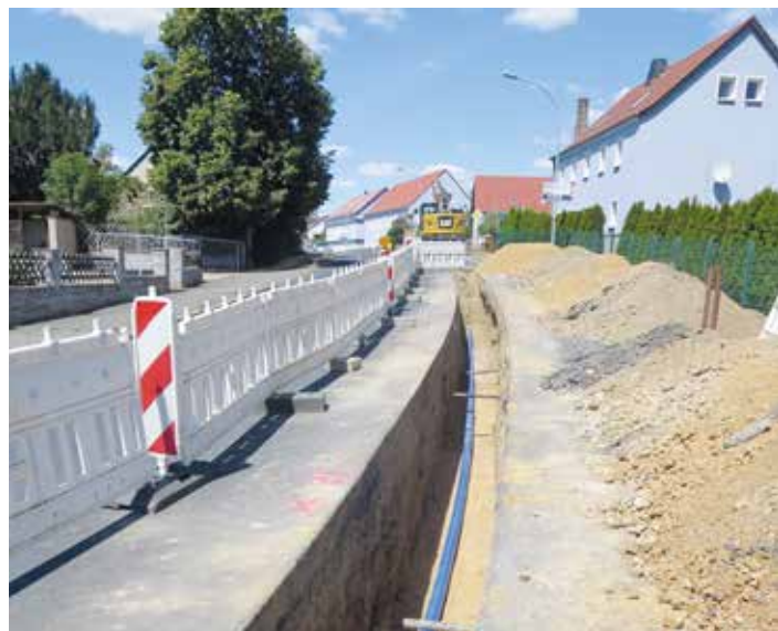
In der Öhringer Straße wird die Trinkwasserleitung neu verlegt.
