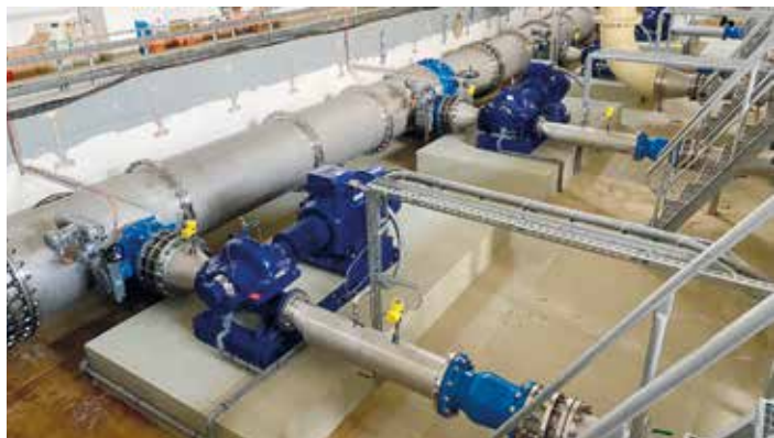
Im Wasserwerk Fichtenberg wurden in den Jahren 2019/2020 die Reinwasserpumpen und der Saugkollektor erneuert. 2020 erfolgt die letzte Teilmaßnahme als „Los 5“.
